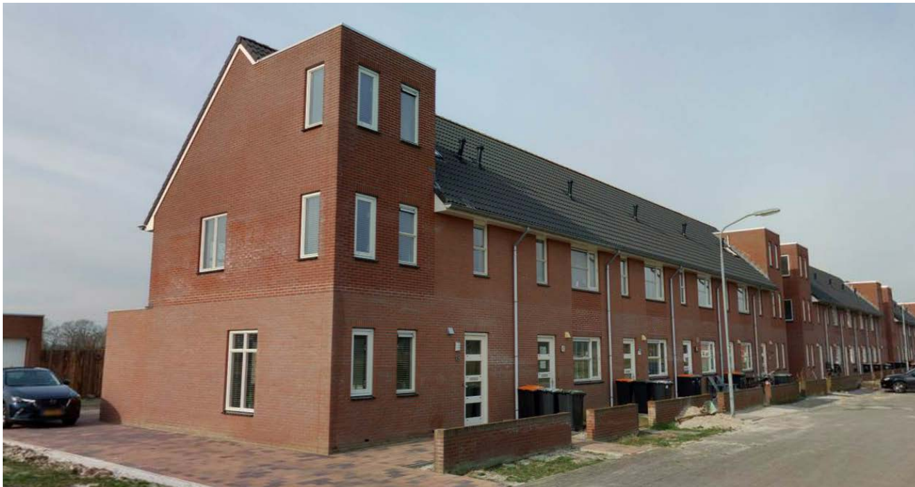
Impressie reeds gebouwde woningen
