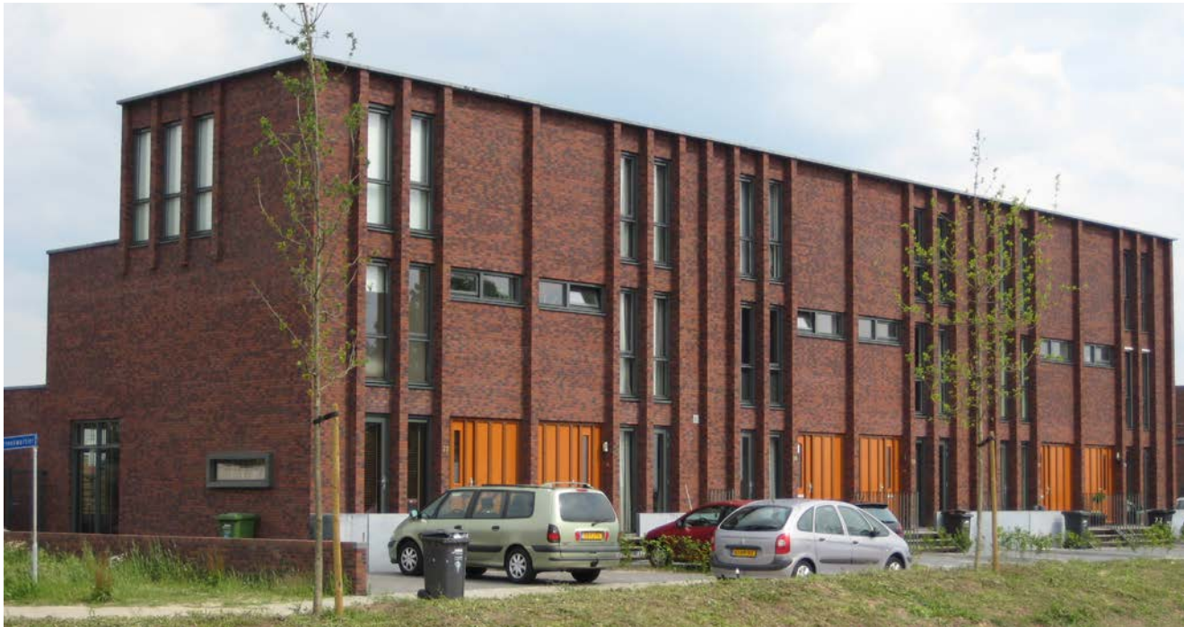
Impressie reeds gebouwde woningen
